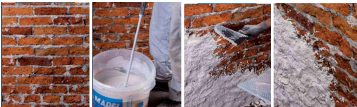
Slika 42. Proces nanošenja temeljne žbuke
