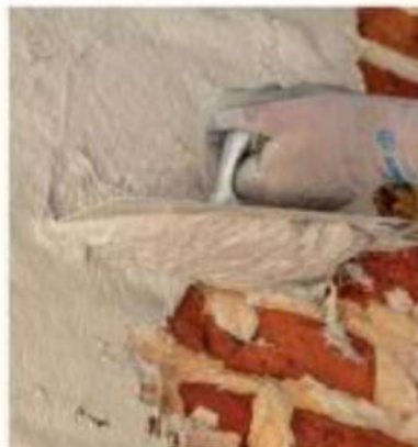
Žbukanje reparaturnim mortom
