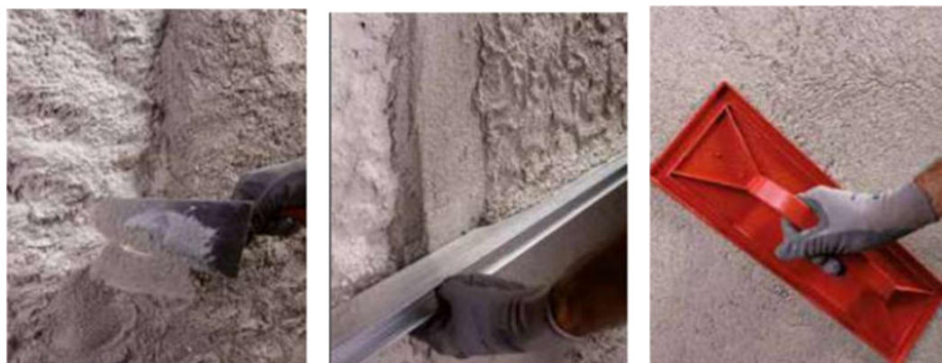
Slika 43. Nanošenje isušujuće žbuke preko temeljne žbuke
