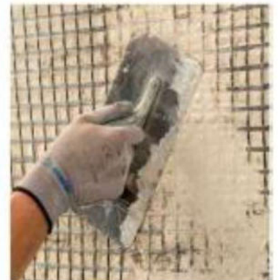
Ugradnja FRCM sustava
