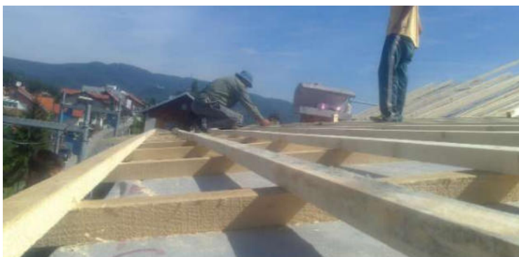
Slika 45. Letve i kontraletve na foliji
