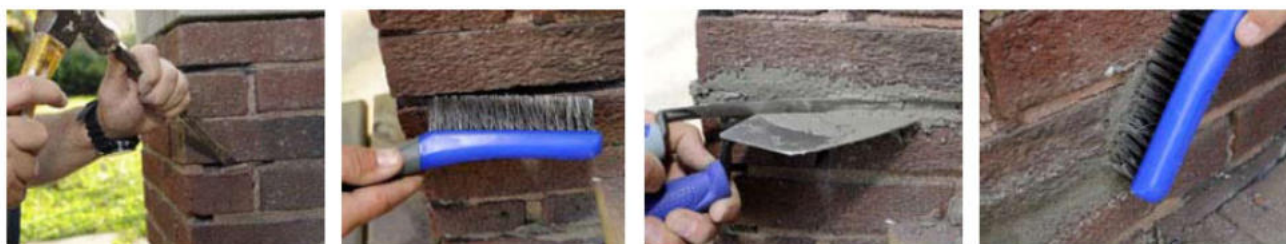
Slika 29. Djelomična zamjena morta u sljubnicama
