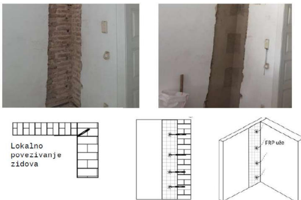
Slika 34. Sanacija spoja nosivih zidova
